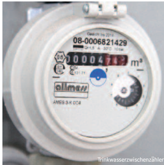
Trinkwasserzweischenzähler
